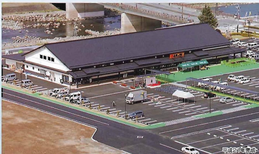
日田天領水の里 元気の駅新築工事(鉄骨造/2251㎡)
