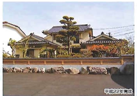
H邸新築工事(木造/223㎡)
