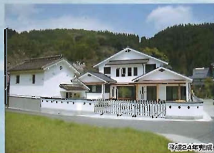
K邸新築工事(木造/230㎡)
