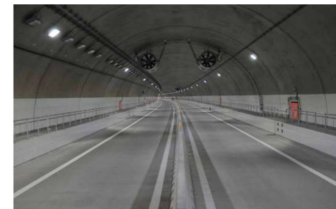
葛原トンネル舗装
