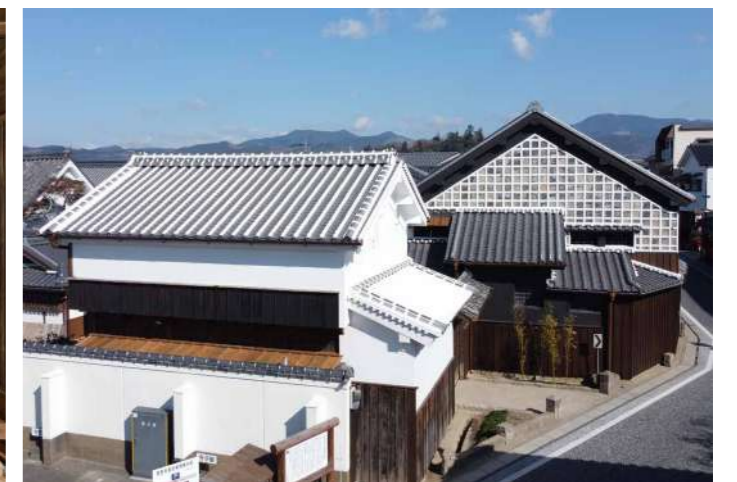
重要文化財 草野本家 【日田市豆田町】 （約7年の歳月をかけた保存修理工事）
