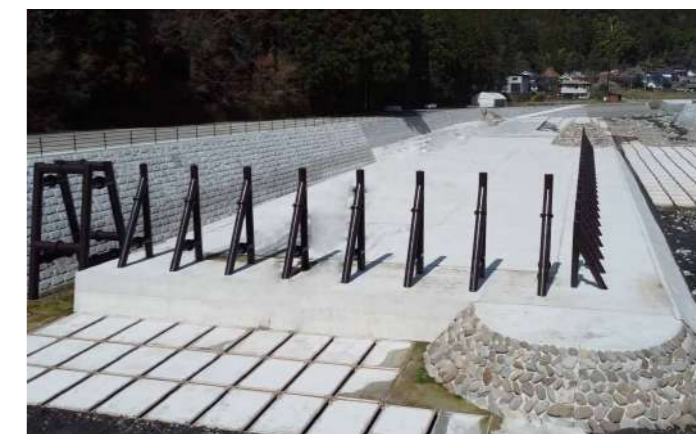
小野川流木捕捉スリット
