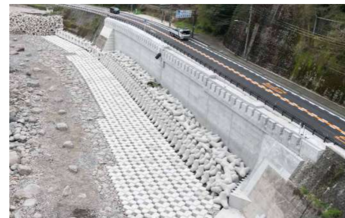
赤岩災害復旧（国道210号）
